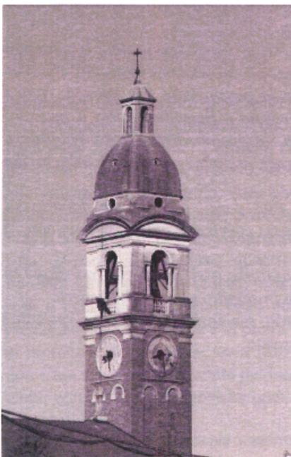
artificiale cementizia (basamento, cella, tamburo, cornici, cupola e lanterna), e la ripresa delle parti rovinate con successiva stesura di un prodotto protettivo a base silossanica. Analogo intervento di pulitura dalle muffe è stato eseguito sul paramento esterno in cotto, con il consolidamento degli elementi ammalorati e la rifugatura in malta ove necessario: anch'esso è poi stato protetto con prodotti a base silossanica.
